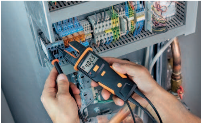
Проверка напряжения на тепловом насосе с testo 755
