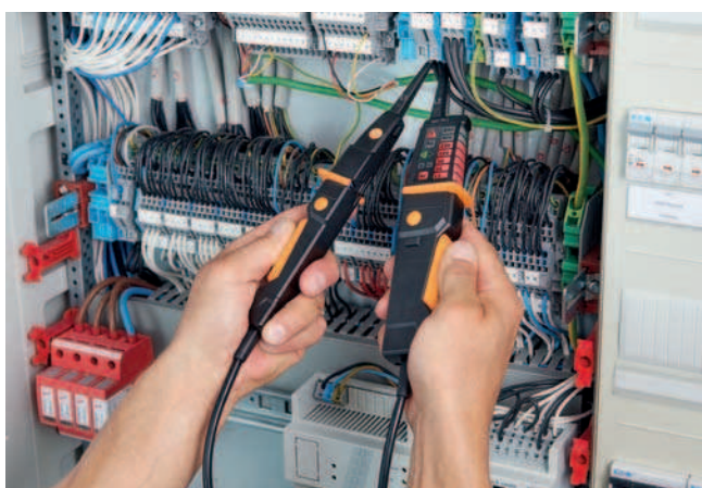
Измерение напряжения в распределительном щитке
