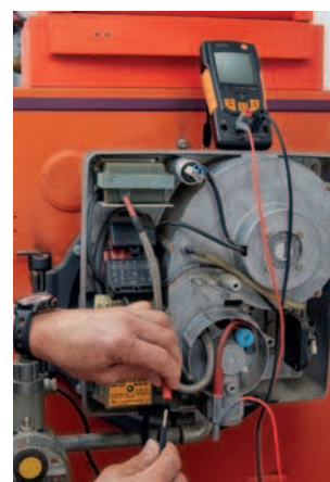
Подготовка к измерению ионизационного тока
