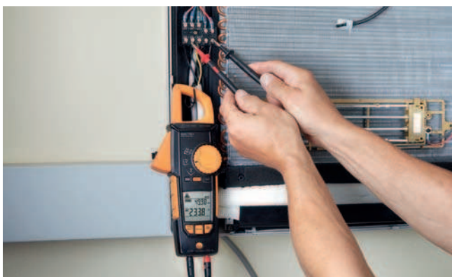
Измерение напряжения на блоке кондиционера с testo 770
