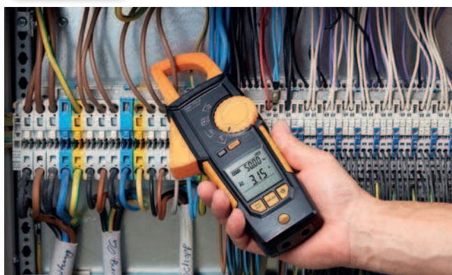
Измерение силы тока в распределительном щитке
