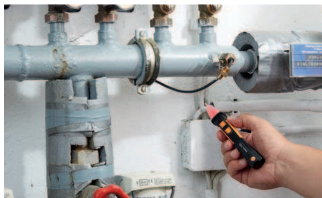
Проверка питания в распределительном щитке с testo 745
